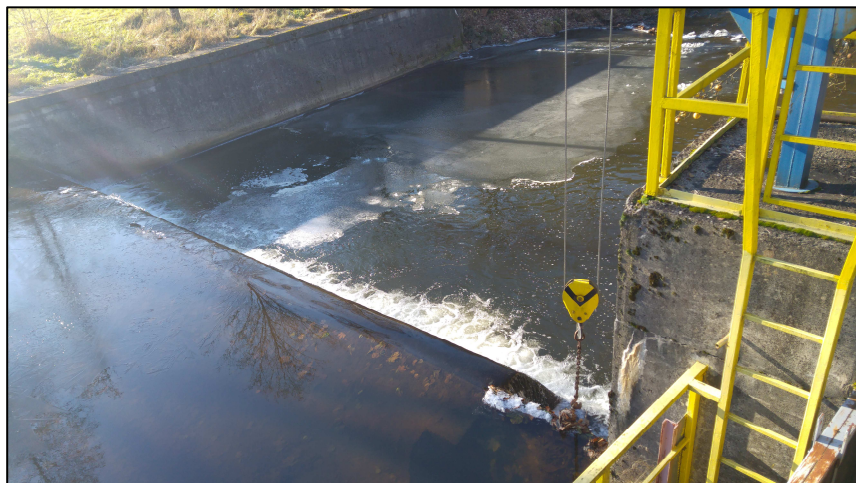
Foto č. 1: Pohled z pravého břehu na přelivnou plochu jezu a na šterkovou propust u pravého pilíře.
